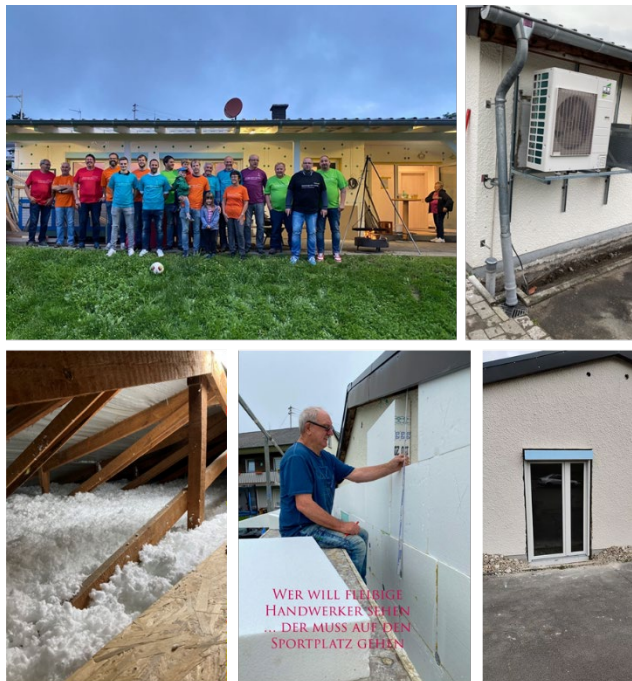
Bild: Sanierungsmaßnahmen am Sportlerheim des SV Longkamp (Fotos: M. Olk, www.svlongkamp.de )
